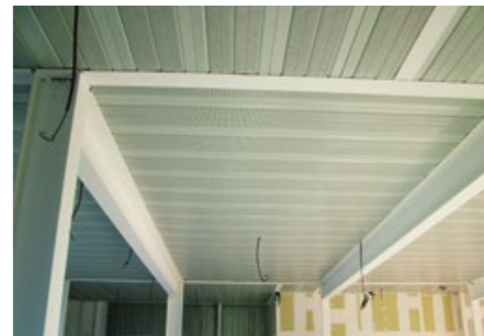
Soffit of Cofradal® Decibel
