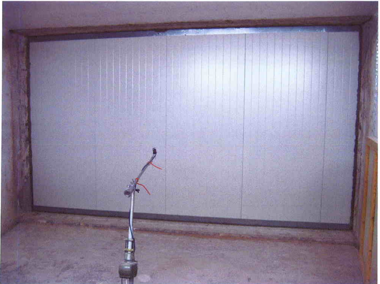
Abbildung 2: Gesamtaufbau der geprüften Wand aus Sandwichelementen, Ansicht Empfangsraum
