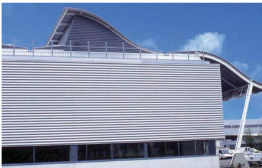
Edifício : Technocentre Renault - Arquitecto : J.F. SCHMIT - Empresa : Sorécob Etanchéité
