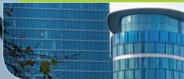
COVENT GARDEN Bruxelles - Architecte : Art Build
