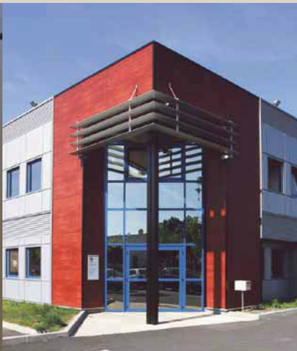
Mazet - ANPE - Architecte : ARCHI 3A.
